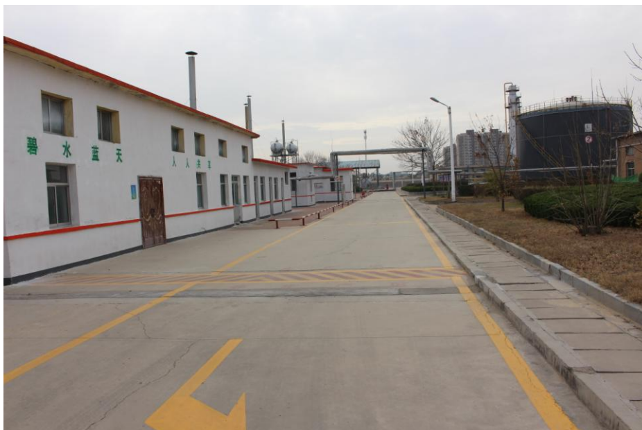
图 7-7 站内地面恢复情况
