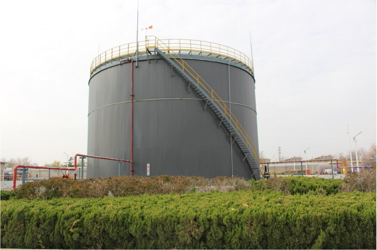
图 8-1 1 号油罐施工情况（一）
