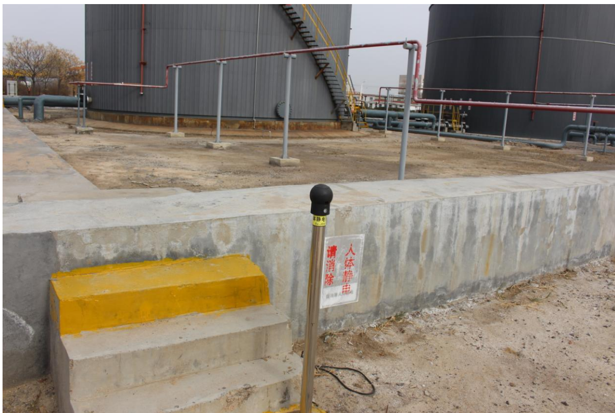
图 8-6 罐区静电消除及接地系统
