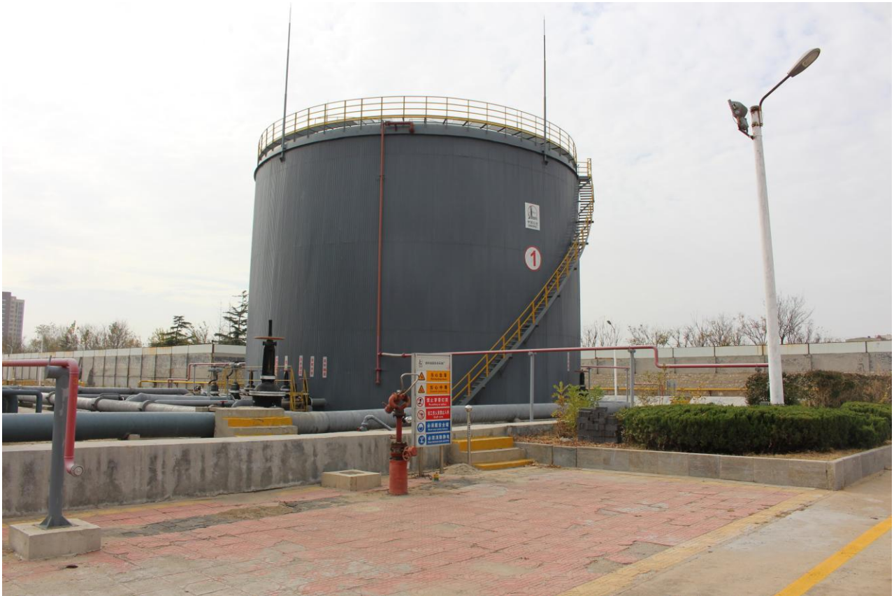
图 5-1 1 号储油罐为事故罐
