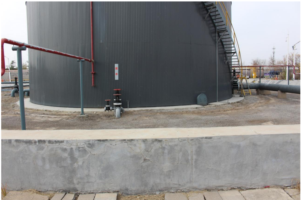
图 8-2 1 号油罐施工情况（二）
