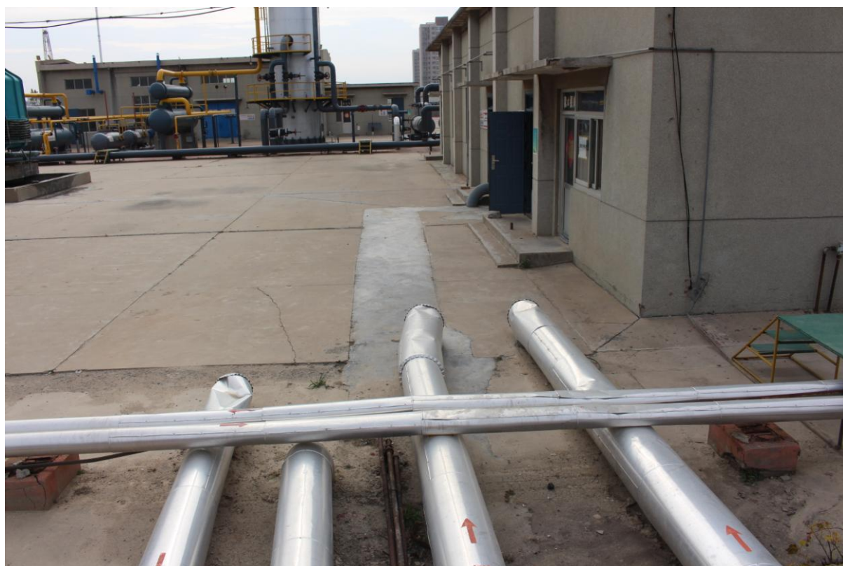
图 8-5 罐区消防管道更新
