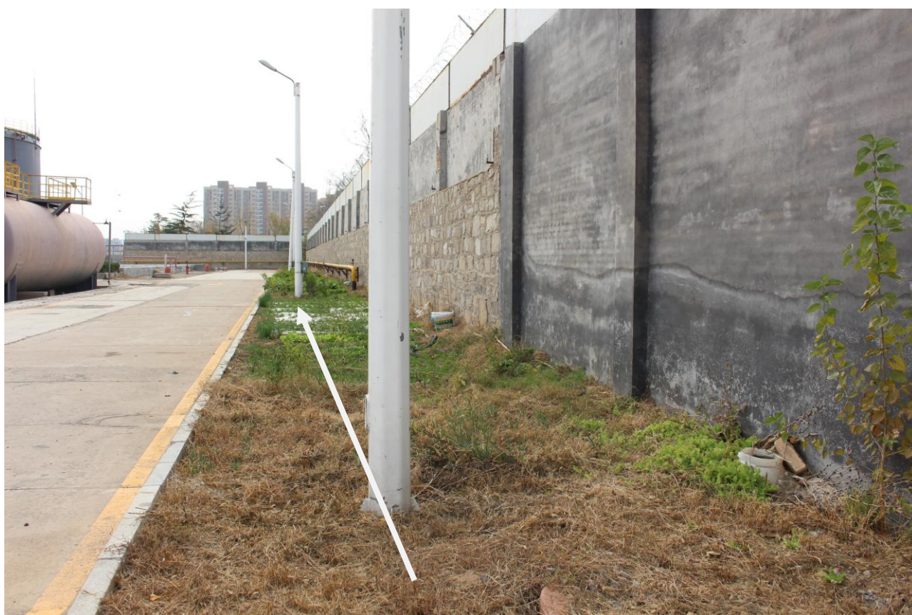
图 8-9 环状罐区冷却水管网
