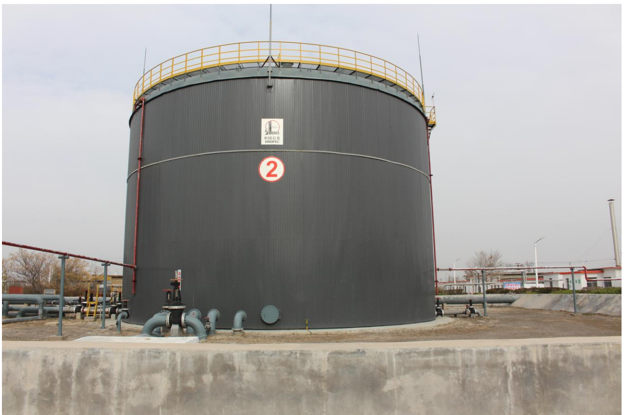
图 8-3 2 号油罐施工情况（一）
