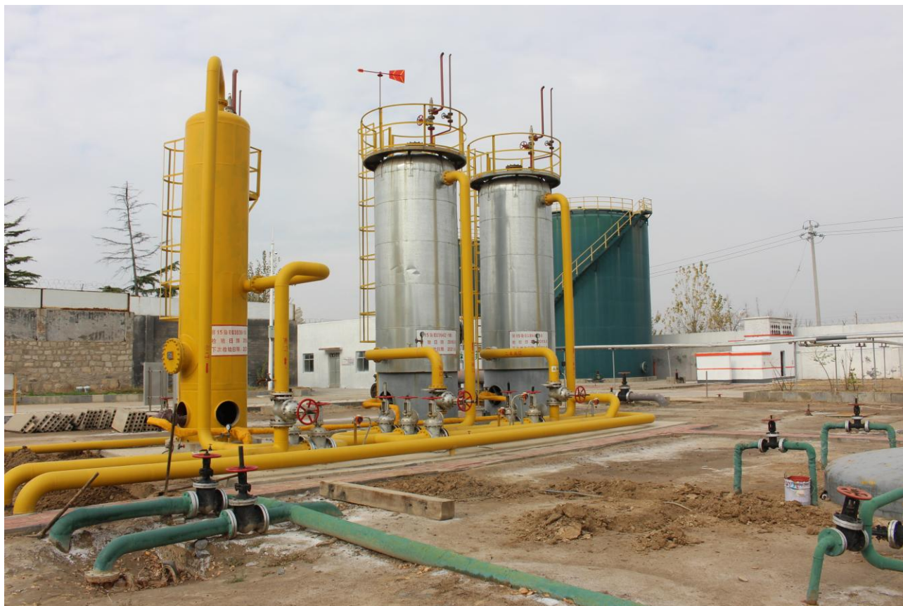
图 8-4 脱硫装置
