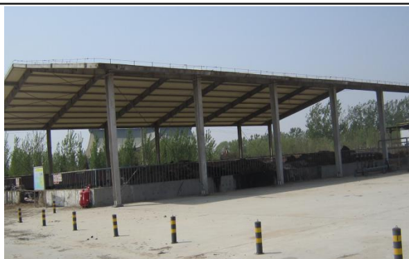
采油管理九区油泥砂贮存场
