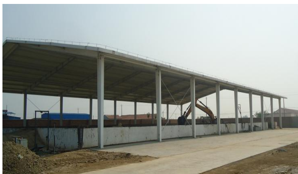
滨一联合站油泥砂贮存场
