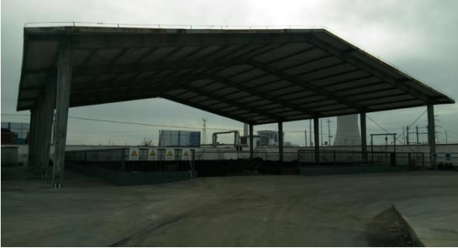
23 号站油泥砂贮存场
