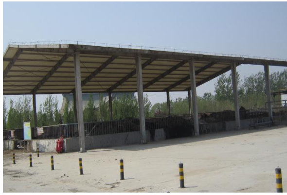
采油管理九区油泥砂贮存场
