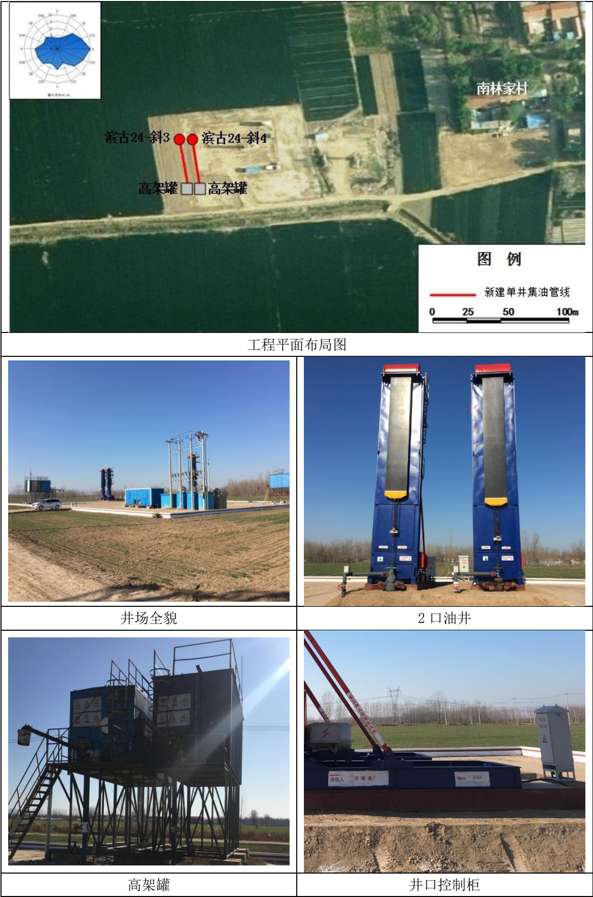
图 3-1 井场平面布局及现场建设情况
