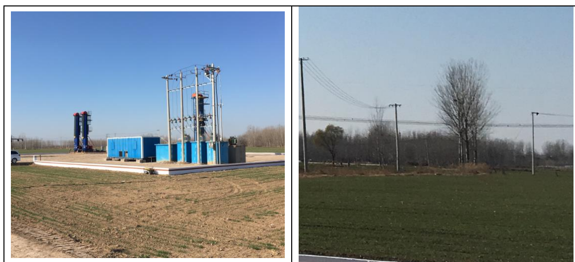
图 6-2 井场施工区域植被现状
