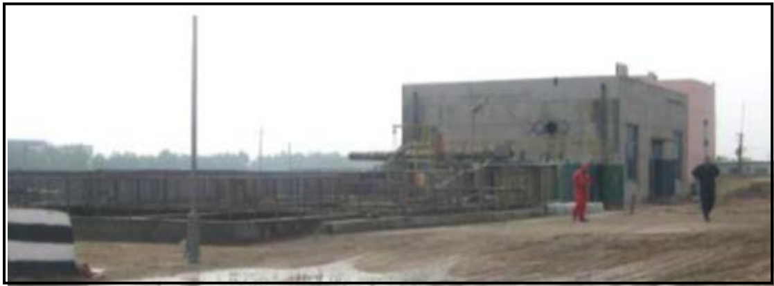
图 3-28 纯梁首站作业废液处理站照
