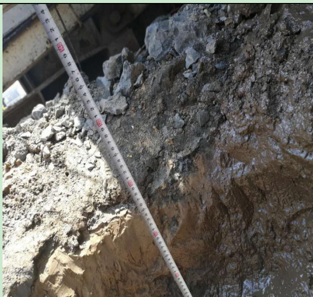
封井施工现场照片 1
