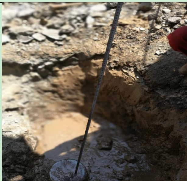
封井施工现场照片 2
