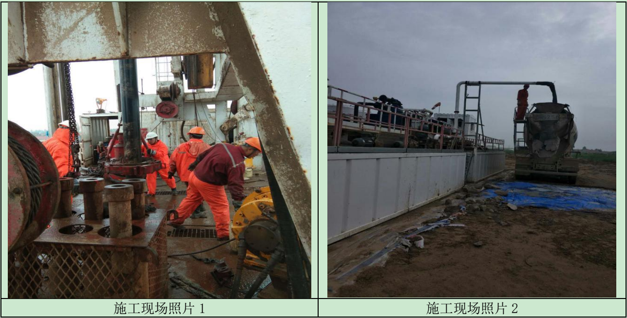
图 1 施工现场照片图
