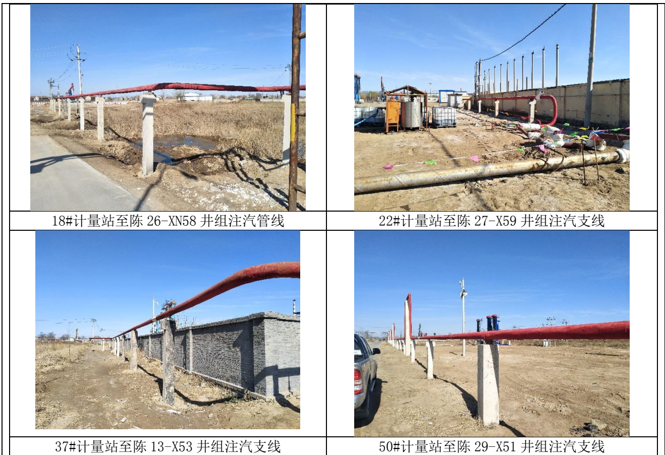
图 1 项目现场照片
