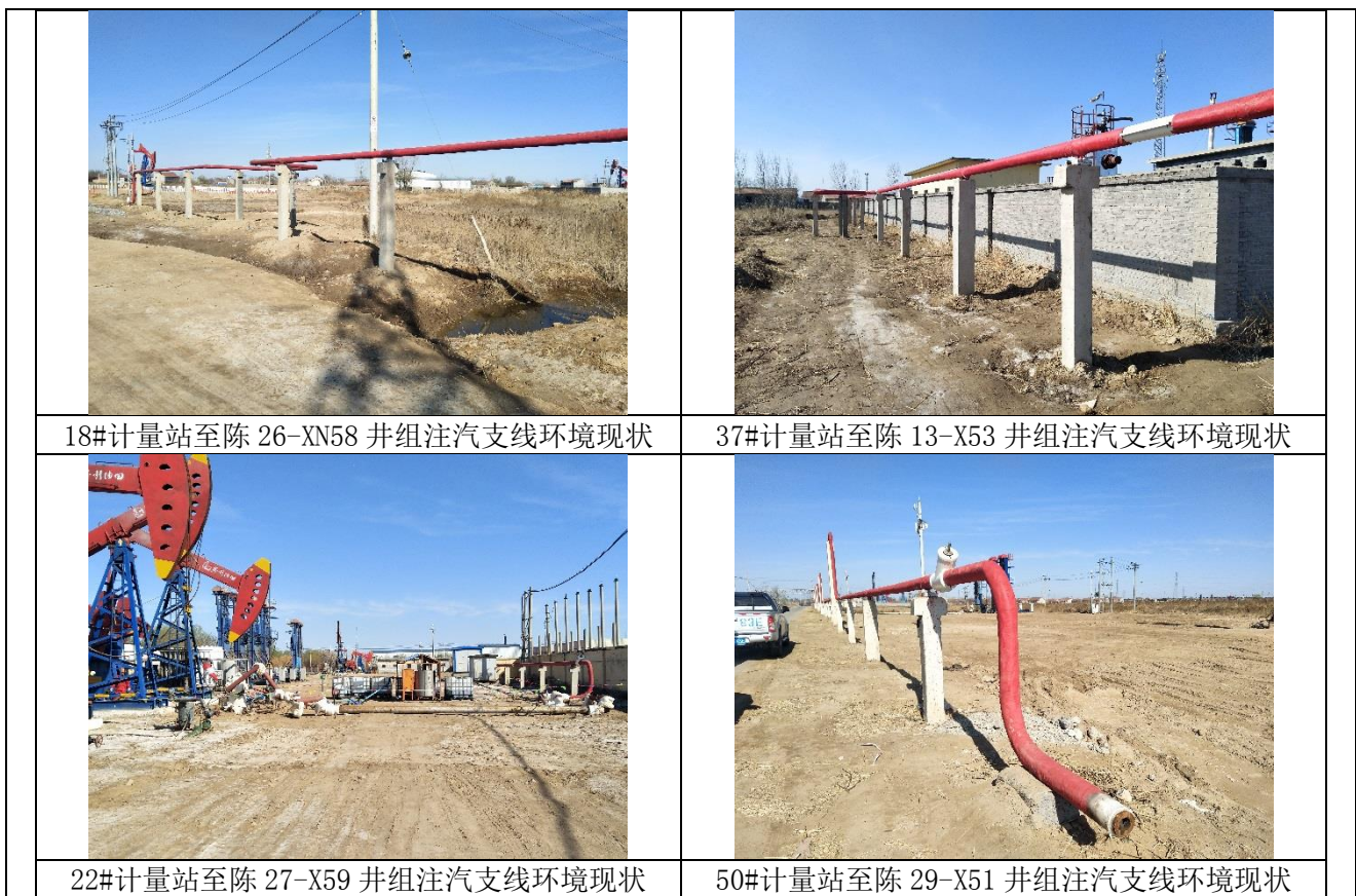
图 4 项目现场照片
